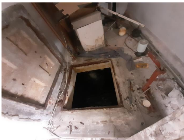
Vista superior de tanque y tapa de acceso e inspección superior permanentemente abierta
